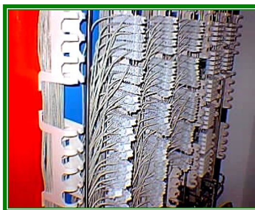
Exemplo da crimpagem dos pontos da rede secundária.
